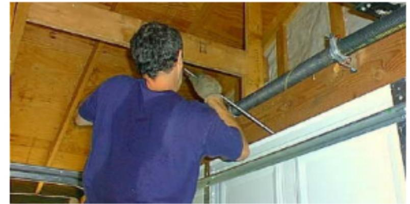
Il est important de vérifier le bon ajustement des ressorts. Tirez sur la poignée de déclenchement manuelle et opérez la porte de façon manuelle.
